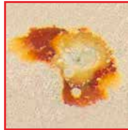
Beispiel für Lochkorrosion
