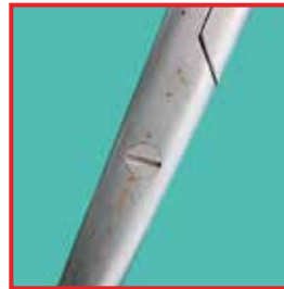
Beispiel für Lochkorrosion
