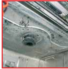
Spülkammer mit starkem Kalkbefall
