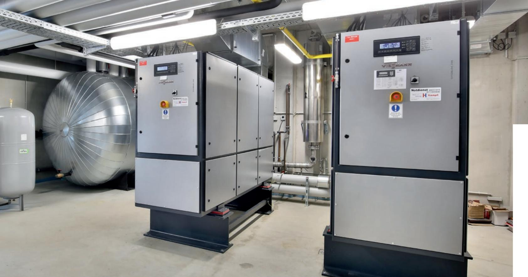
Zwei mit Gas betriebene Blockheizkraftwerke vom Typ Vitobloc 200 von Viessmann liefern den Strom und die Wärme für die Zentralwäscherei im BRK Senioren-Wohn- und Pflegeheim Plattling. Links davon steht der acht Meter lange Pufferspeicher, der 20.000 Liter Wasser fasst.
