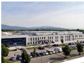
Photo 4 : Usine Steelco à Riese Pio X (photo : Steelco)
