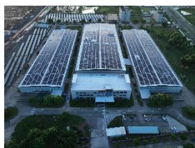
Photo 3 : Dans l'usine Miele de Dongguan, en Chine, 9'550 panneaux solaires produisent 5'100 mégawattheures d'électricité par an, ce qui est largement suffisant pour alimenter entièrement l'usine. (Photo : Miele)
